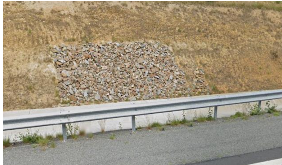
Figure 80 : Exemple d'empierrement ponctuel réalisé sur un talus routier
